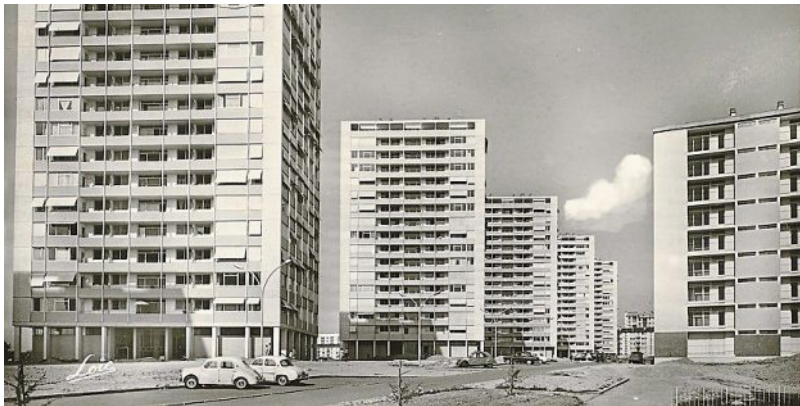
Les tours de la cité du Gros-Chêne, dans le quartier Maurepas, à la fin des années 1960. | CRÉDIT PHOTO : COLLECTION MUSÉE DE BRETAGNE ET ÉCOMUSÉE DU PAYS DE RENNES
